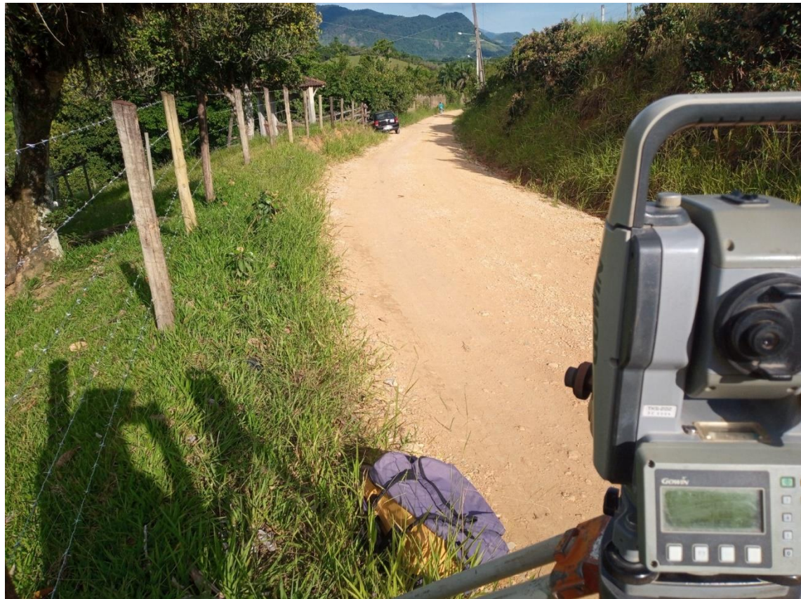
Fotos Registrada em Campo ESTAÇÃO TOTAL ( Ft. 02)
