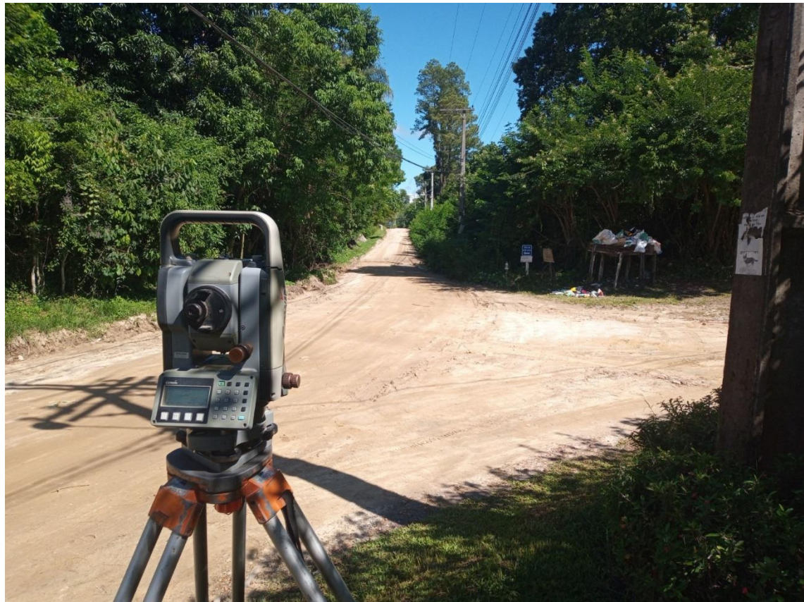
Fotos Registrada em Campo ESTAÇÃO TOTAL ( Ft. 01)
