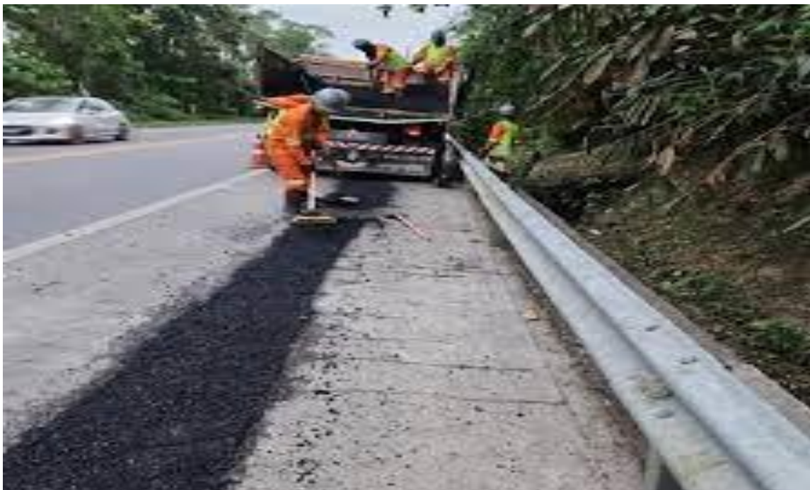
Figura 17– Fechamento da Vala
