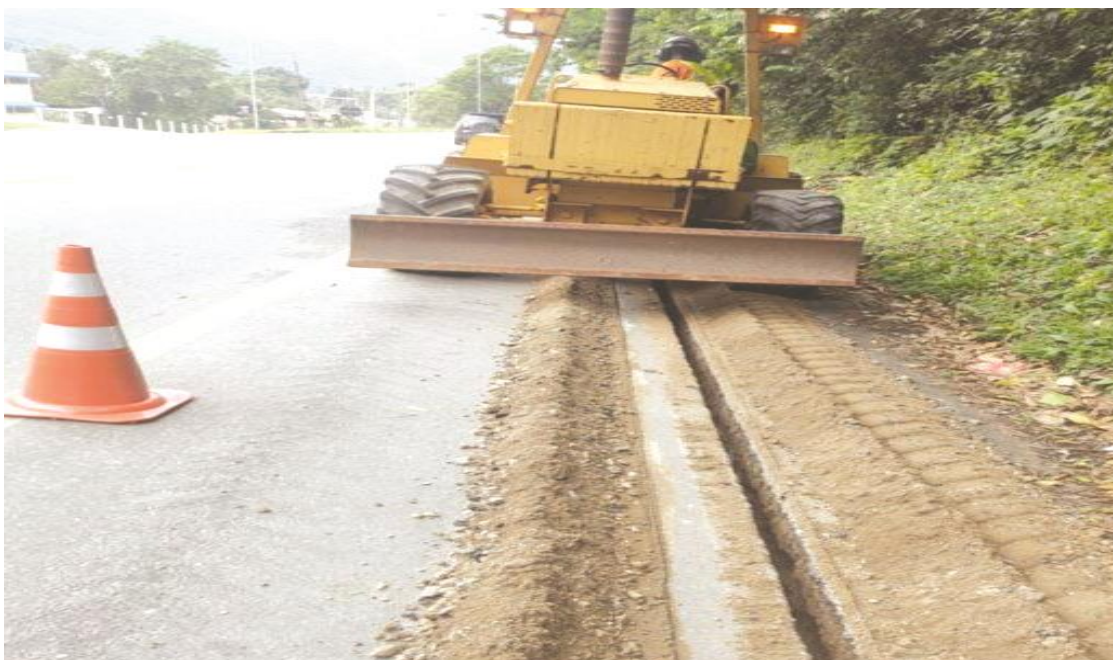
Figura 15– Abertura da Vala
