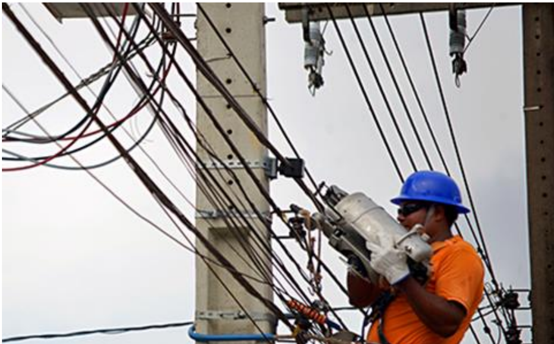
Figura 18– Lançamento de Cabo Óptico
