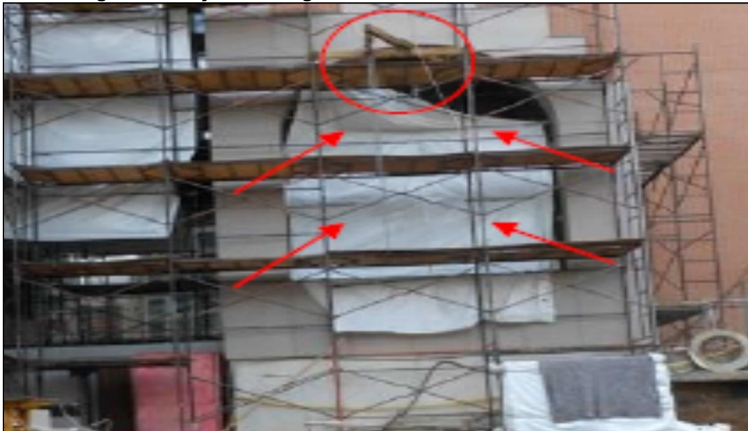
Figura 14 - Içamento ligado a andaime em ambiente externo
