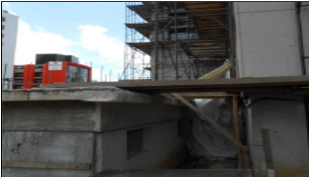
Figura 13 - Andaime apoiado em ambiente externo
