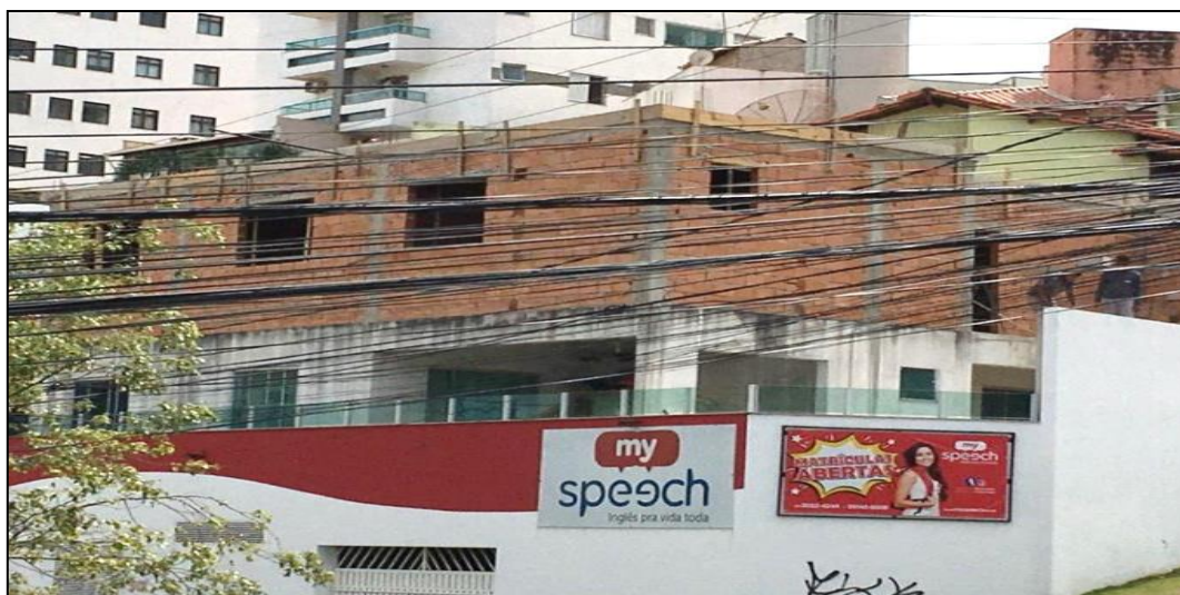
Figura 15 - Primeira reforma residencial realizada pela E.V.E.
