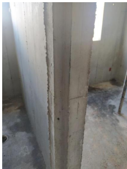
Figura 67 - Saliência na aresta da parede.
