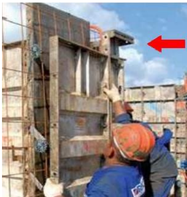
Figura 15 – União parede-laje
