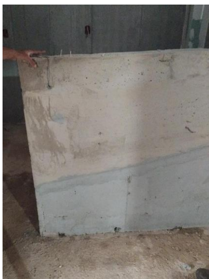
Figura 58 - Juntas de concreto
