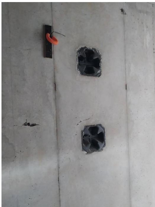
Figura 37 - Espera da instalação elétrica
