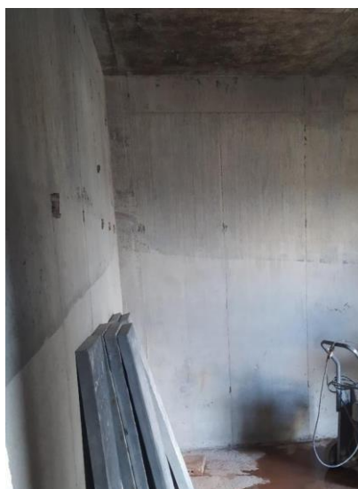
Figura 59 - Juntas de concreto.
