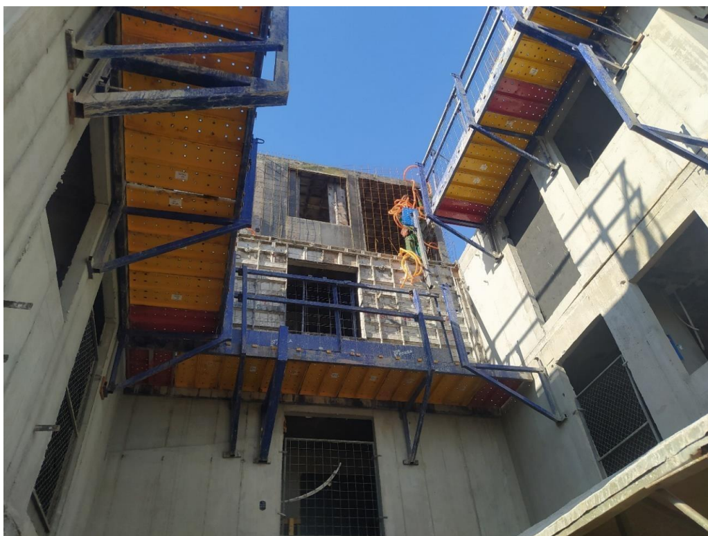
Figura 34 - Montagem das fôrmas
