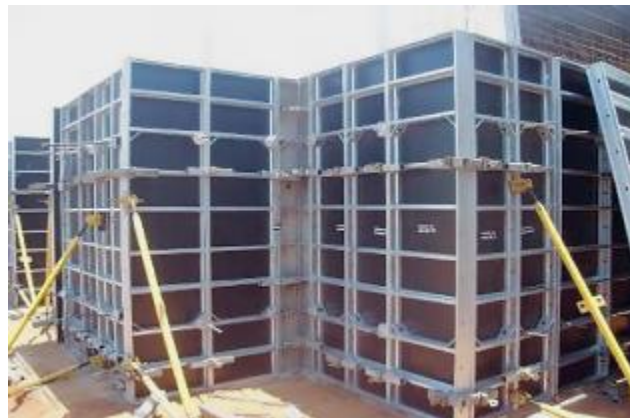
Figura 8 - Fôrmas de aço em um reservatório.
