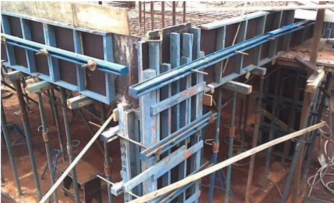
Figura 6 - Fôrmas de madeira revestida pronta.
