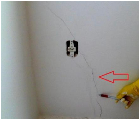
Figura 26 – Fissura
