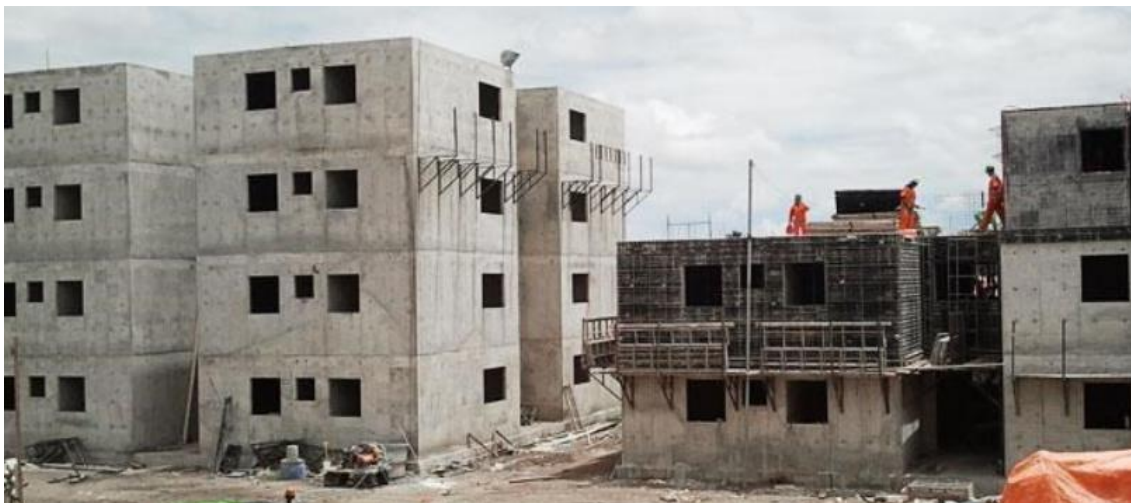
Figura 3 - Edifício sendo construído com paredes de concreto.
