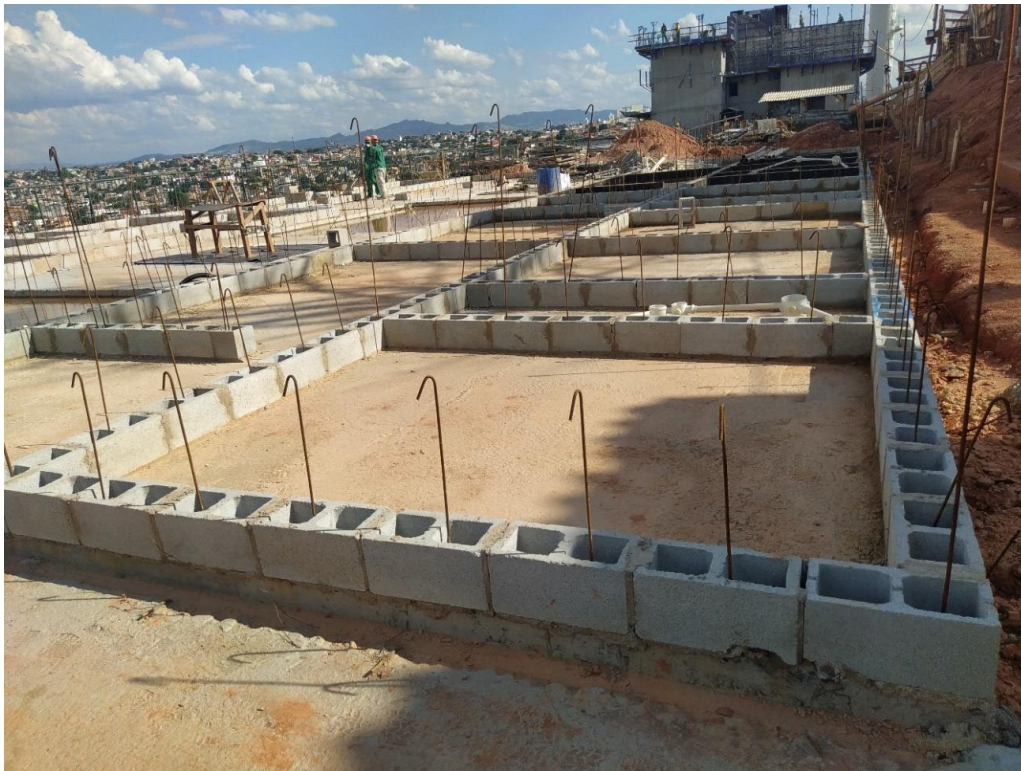
Figura 31 - Platô, primeira fiada e arranque da armação.
