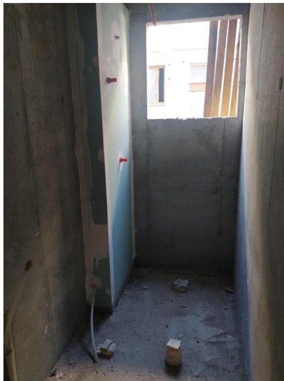
Figura 32 - Shaft do banheiro
