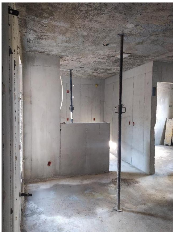
Figura 35 - Escoras da laje
