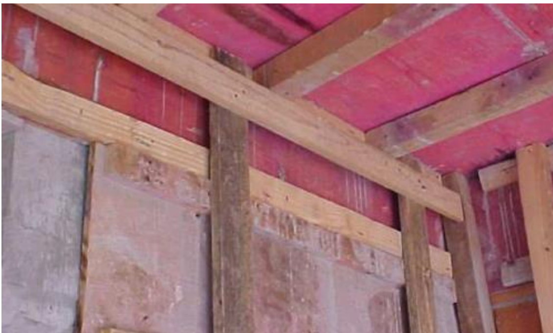
Figura 5 - Fôrmas de madeira serrada.
