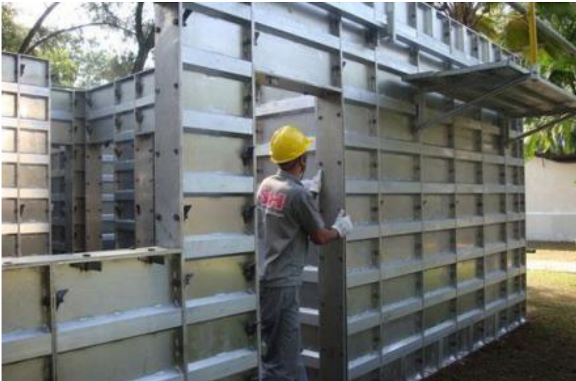
Figura 9 - Fôrmas de alumínio
