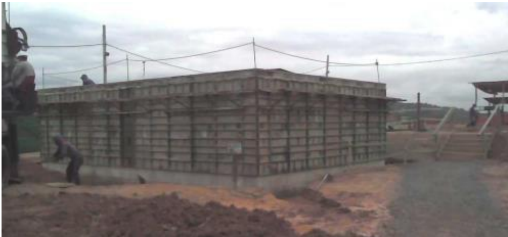
Figura 7 - Fôrmas de aço em um reservatório
