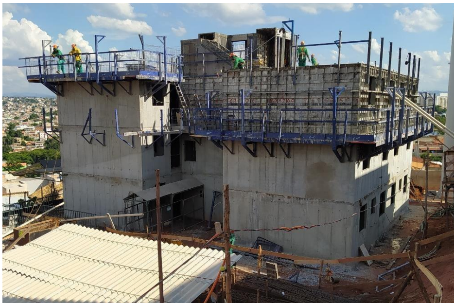
Figura 33 - Montagem das fôrmas
