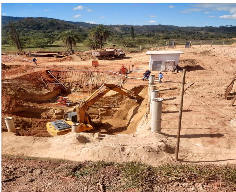
Imagem 3: Escavação com as ponteiros
