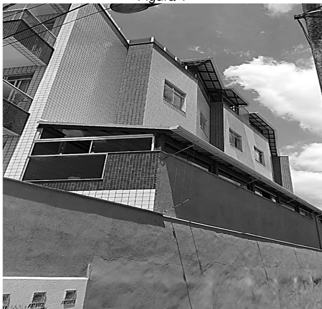
Edifício Flamboyant. Fissura na parede Fonte: Autores 2019.
