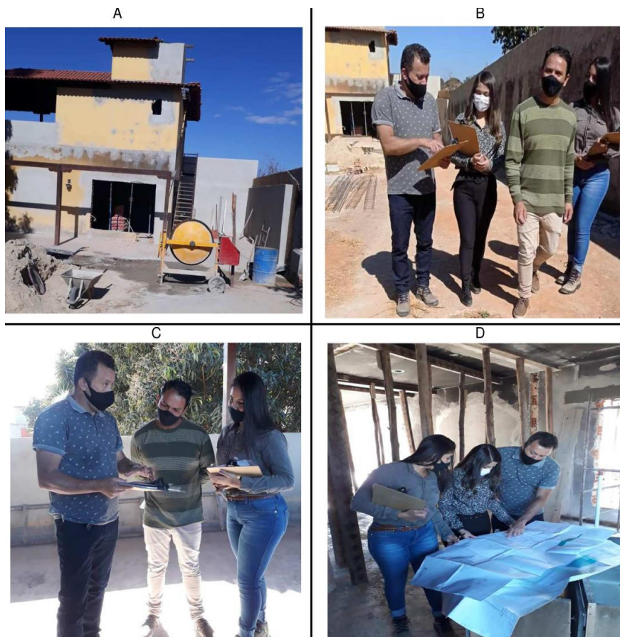
Figura 12 - Etapas sobre a realização da visita técnica no canteiro de obra
